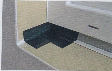
**Schritt 8:** Kleben Sie das Butylband des SlidePro-Fensterbank-Dichtsystems auf die Fensterbankfläche und den Fensterahmenübergang.
