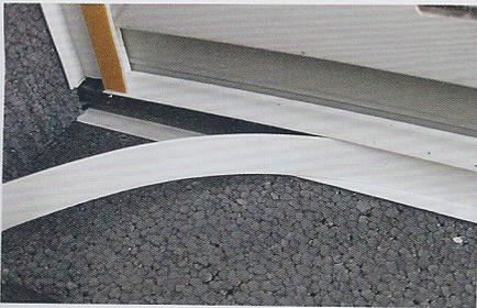
**Schritt 4:** Entfernen Sie die weiße PVC-Abdeckung des im Werk vormontierten Dichtbands am Fensterrahmen. Das aktivierte Band expandiert dann selbstständig innerhalb von zirka 30 Minuten. Sie können trotzdem sofort weiterarbeiten.
