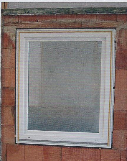
**Schritt 1:** Die Vorbereitung der Laibung und der Fenstereinbau funktionieren wie gewohnt nach dem Stand der Technik. Details dazu finden Sie im Praxistipp der GFF-Ausgaben 7-8 und 9/2010. Die Systemfenster sind vorgebohrt.
