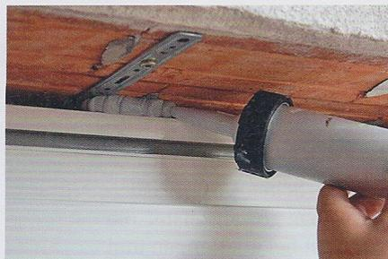
**Schritt 2:** Mit einer Pistole spritzen Sie speziell entwickelte Dichtmasse, die EMV mit dem Fenstersystem liefert, in die Hohlräume zwischen Laibung und Fensterrahmen. Damit schaffen Sie einen luftdichten Anschluss von der Innenseite aus.
