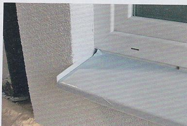
**Schritt 10:** Nach dem Edelputzauftrag schieben Sie das Fensterbankblech ein und schrauben es fest.
