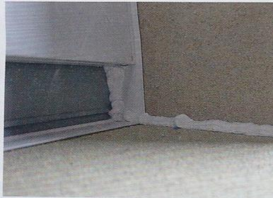
**Schritt 7:** Mit dem EMV-Universal-Klebe-Dichtstoff in der Spritzpistole fügen Sie die Innenecken ab. Den Dichtstoff liefert EMV mit dem Fenstersystem. Danach trägt man die Armierungslage oder den Grundputz auf die Fassade auf.
