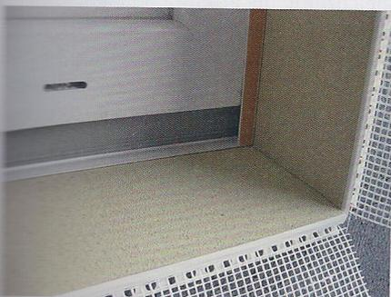
**Schritt 6:** Als ersten Teil des Fensterbankanschlusses nach RAL schieben Sie die Keilplatte wie die Laibungsplatte in die Schiene.
