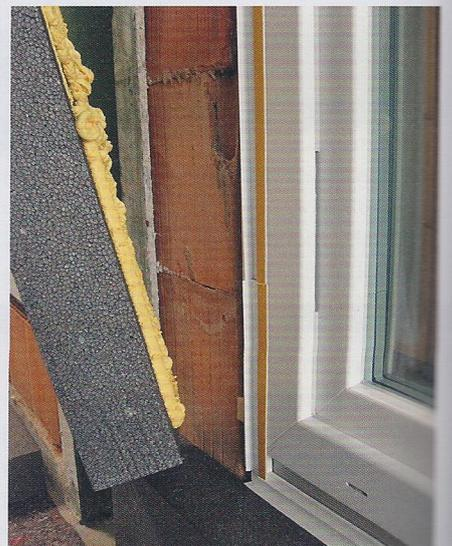
**Schritt 3:** Jetzt montieren Sie das Wärmedämmverbundsystem mit Klebeschäum oder Klebemörtel auf das Mauerwerk. Die Dämmplatten stoßen an die Systemfenster-Anschlussleiste an. Es gibt einen definierten Punkt für den Anschluss am Fenster.
