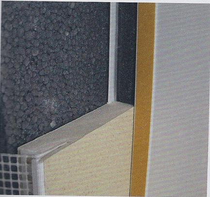
**Schritt 5:** Bei der Laibungsplattenmontage schieben Sie zuerst die Sturzplatte oben in den Systemfenster-Anschluss. Zur Auswahl stehen verschiedene Laibungsplattensysteme (Steinwolle, XPS, EPS, Polyurethan, Resol, Holzweichfaser). Mit einem 1-K-Polyurethan-Klebeschäum verkleben Sie die Sturzplatte zur Fassadendämmplatte hin – Mörtel ist nicht nötig. Bis zum Austrocknen des Schaums fixieren Sie die Platte mit herkömmlichen Nägeln, die Sie dann wieder entfernen.
