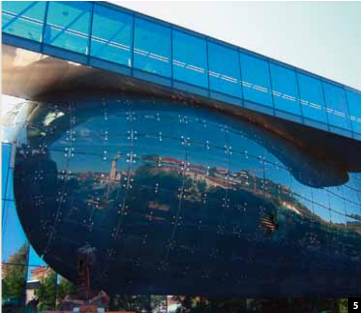
Abb. 5: Am Kunsthaus Graz wurden Punkthalter zwischen den einzelnen Platten eingesetzt. Besonders der Brandschutz war bei diesem Projekt eine Herausforderung.
