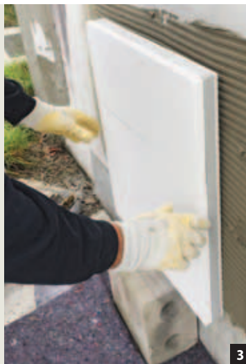
Abb. 1: Die neue Dämmplatte „epalith tp 3 “ von epasit besteht aus einer Trägerplatte aus Calciumsilikat, dem Hochleistungsdämmstoff „Calostat“ sowie einer Calciumsilikatplatte mit geringer Rohdichte als Feuchteregulierungsschicht.
