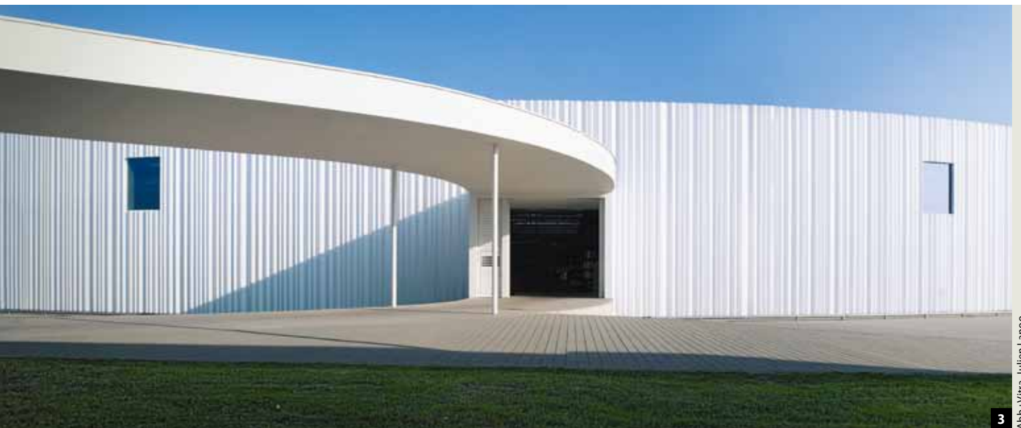
Abb. 3: Für die Fassade des Vitra Factory Centers in Weil am Rhein wurden zwölf Meter große Platten extrudiert und wellenförmig umgeformt. Der Wunsch der Sanaa-Architekten war eine Fassade, die aussieht wie ein Vorhang.
