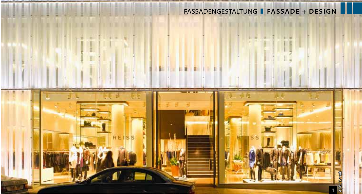
Abb. 1: An der Fassade des Hauptsitzes der Modefirma Reiss in London kamen in unterschiedlichen Tiefen und Strukturen gefräste Acrylgaselemente zum Einsatz. In Kombination mit der Transluzenz entstehen spannende Lichtbrechungen.
