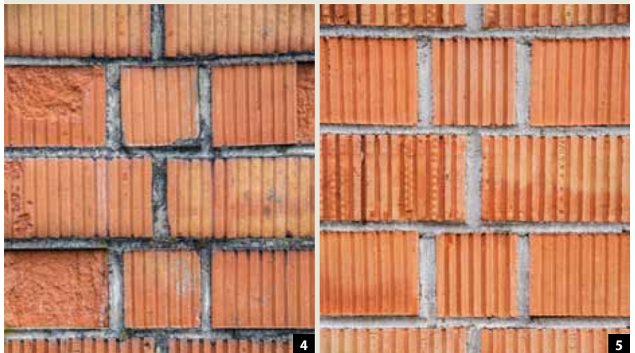
Abb. 2–5: Wie Steinmauern aus Kalksandstein und Ziegel durch Schutzsysteme auf Silanbasis geschützt werden können, veranschaulichen die Fotos. Sie zeigen jeweils eine unbehandelte (Abb. 2 und 4) und eine behandelte (Abb. 3 und 5) Kalksandstein- beziehungsweise Ziegelwand nach 16 Jahren Außenbewitterung in Süddeutschland. Die Schäden durch Ausblühungen, Abplatzungen, Schimmel- und Mooswachstum sind auf den unbehandelten Mauern unverkennbar.
