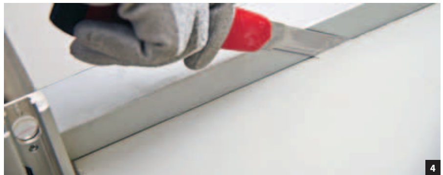
Abb. 4: „Calostat“ kann mit jeder handelsüblichen Säge mit einem Standardsägeblatt für Dämmstoffe oder Holz gesägt werden. Wird mit einem Messer oder Cutter geschnitten, sollte eine Führungsschiene angelegt werden.
